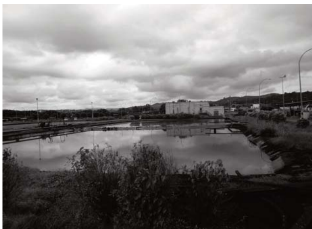
Refinería Esmeraldas. Piscina de desechos (Foto. A. Almeida. 2010)
