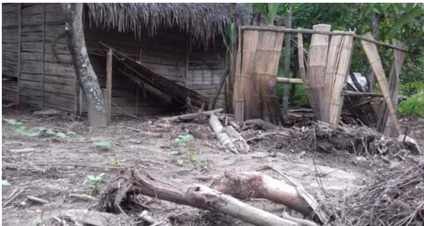
Figura 5.2 Casas dañadas por el deslave
