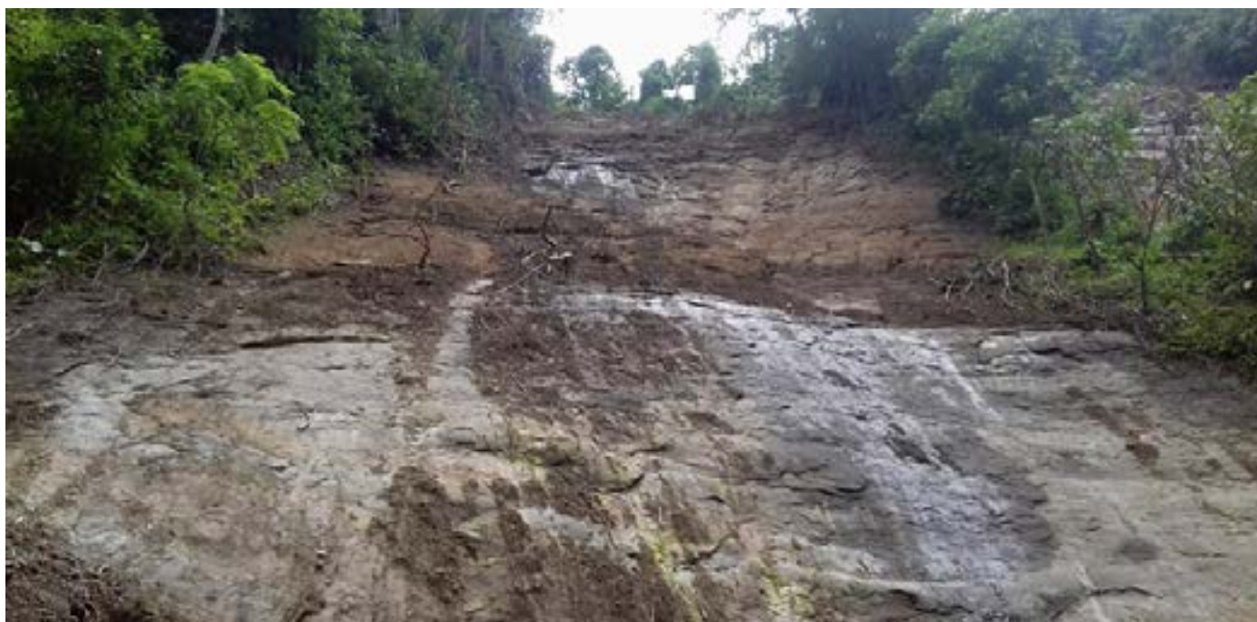
Figura 5.6 Erosión del suelo, deslave debido a la tala de balsa
