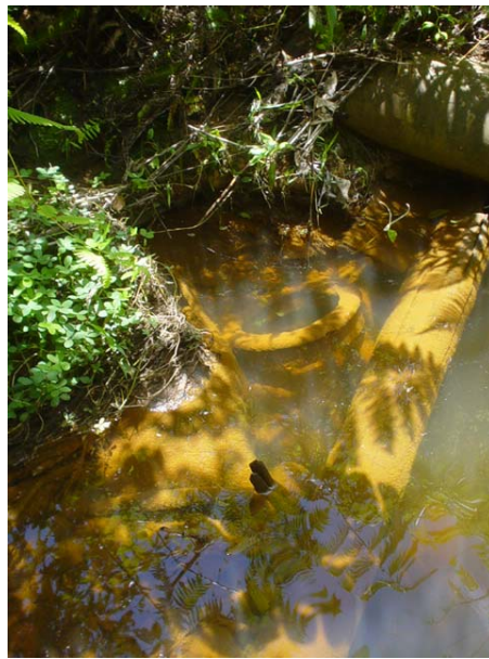
Estero contaminado con restos de tuberías
