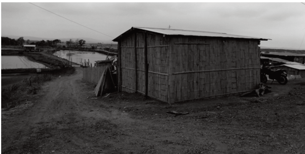
Casa reconstruida, junto a una camaronera en el Cantón Sucre
