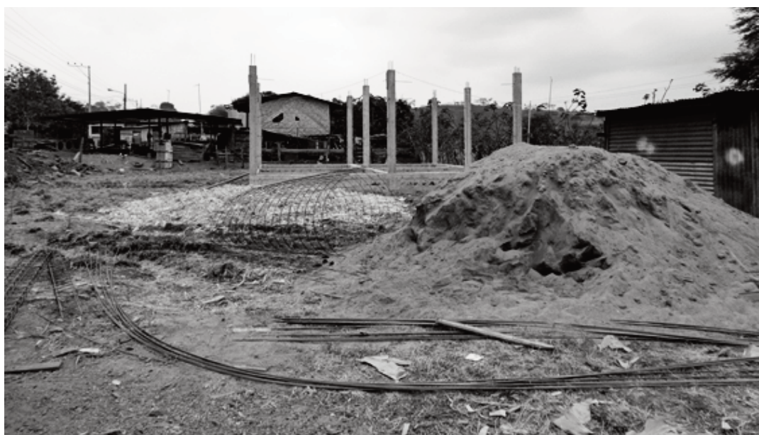
Zonas afectadas por el terremoto. Zona rural de Rocafuerte - Manabí
